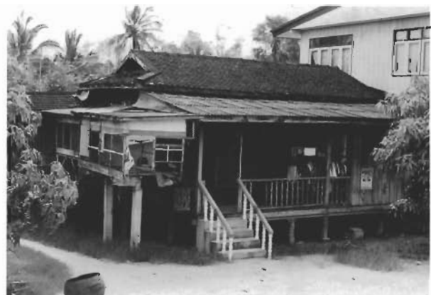
บันไดขึ้นเรือนแบบทำด้วยปูนซีเมนต์ มีทั้งลูกตั้งและลูกนอนพร้อมราวบันไดสวยงาม
