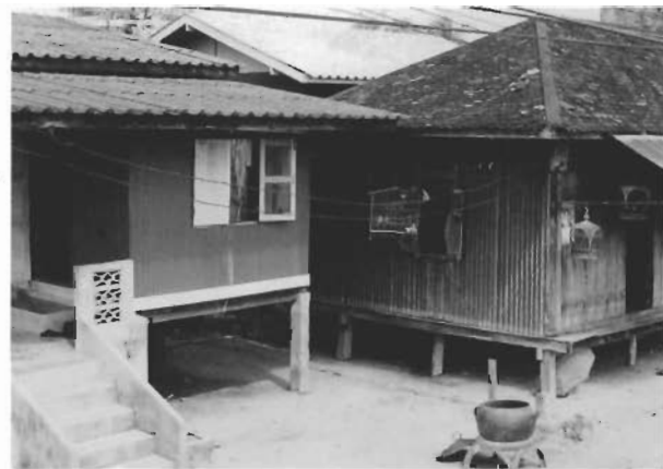
ฝาผนังเรือนที่ใช้วัสดุที่เป็นไม้และสังกะสีผสมกันและอาจมีสังกะสีที่ตกแต่งด้วยสี และสีที่นิยมคือสีเขียว
