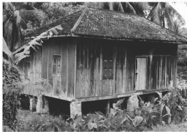
เสาบ้านก่อด้วยอิฐล้อมรอบเสาไม้ที่อยู่ด้านใน เพื่อป้องกันการกัดเซาะของน้ำในช่วงฤดูฝน
