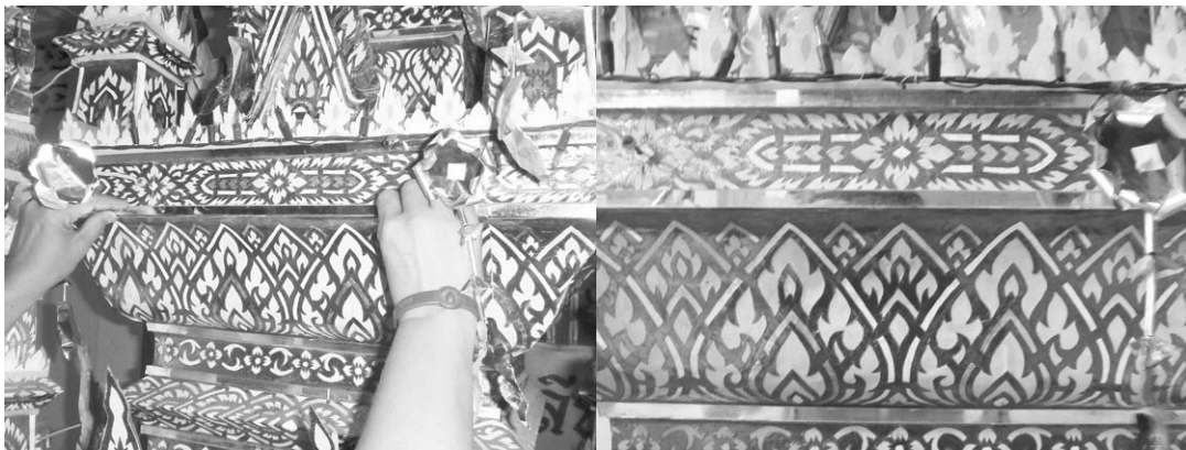
รูปที่ 9 ภาพแสดงการติดลายกนกและการประดับกระจก
